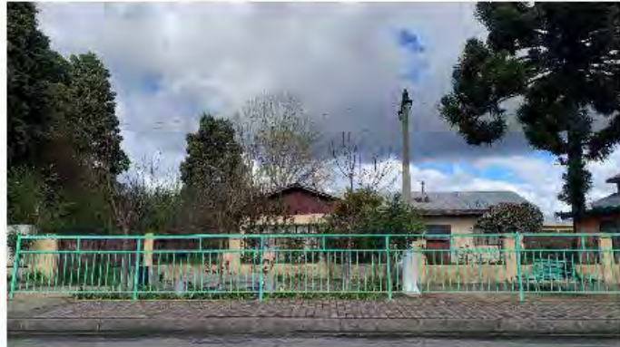
Vallas jardineras calle Ahumada – Monte Aguilá
