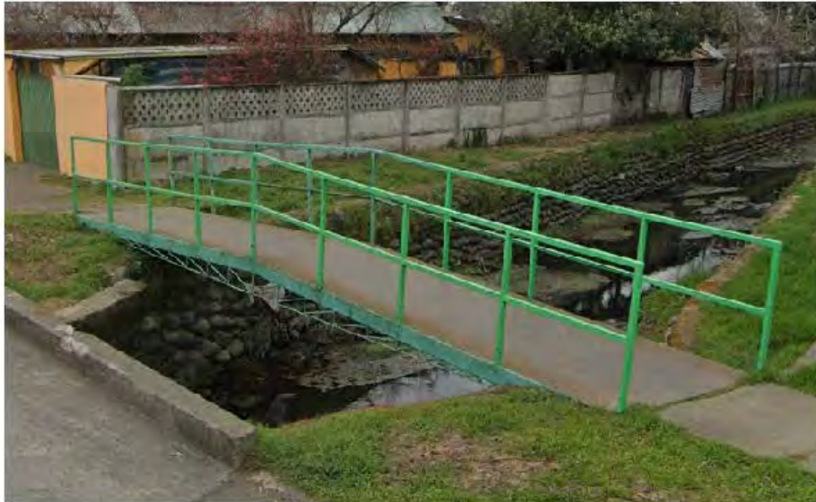
Puentes peatonales – Calle Membrillar, Cabrero
